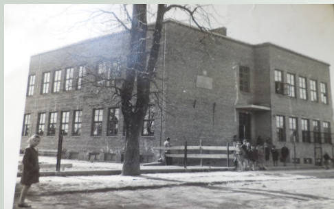
Budynek szkoły z lat 60. XX w.
